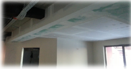
*spuščeni stropovi in kaskade, podkonstrukcije suhomontažnih stropov
